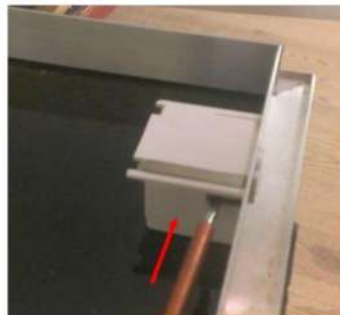
2 / Réamorçage du boîtier à l'aide d'un tournevis plat : Placez le tournevis dans l'espace situé sur le côté du boîtier.
